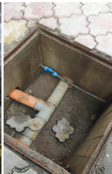
3. Instalatii de apa si canalizare suprapuse
