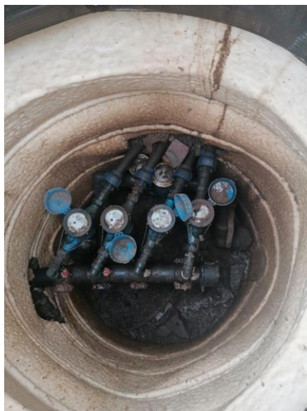
1. Instalatii de apa intercalate si interconectate
